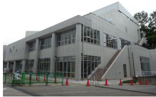
2016年9月竣工予定の新校舎 1階にはトレーニングセンターを新設
